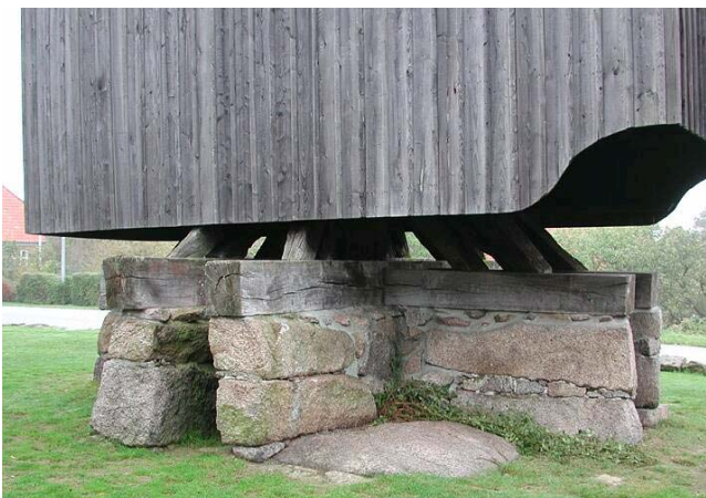
2001, svamp og store revner
