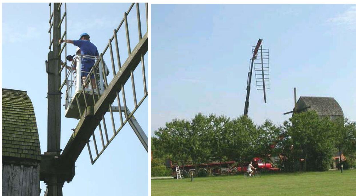
Med kran og lift tages vingerne ned , en for en, 18.aug. 2004.
