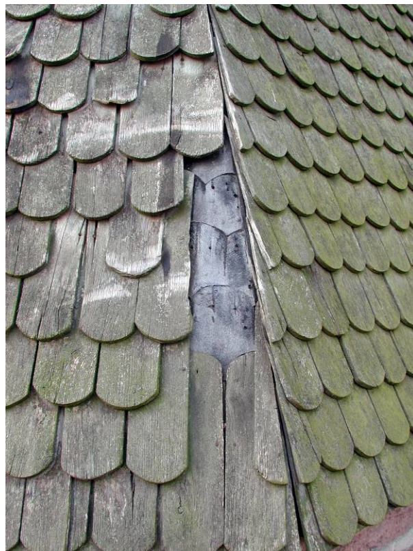
Forkert hjørnesamling. Pap med huller.
