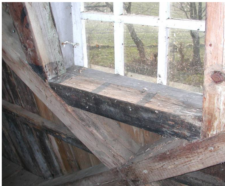
Simpel reparation og ny vinduesramme uden profiler.
