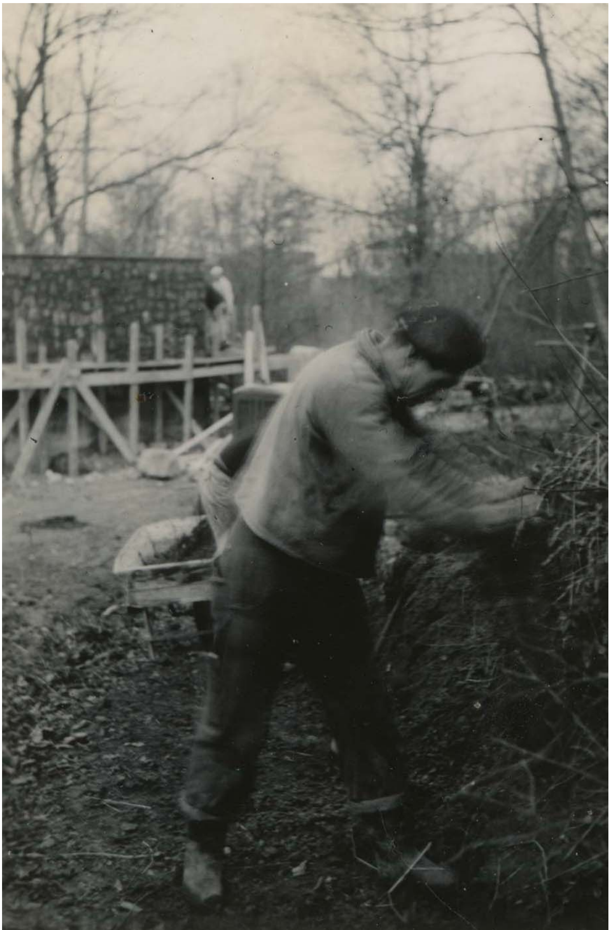
I baggrunden ses Svaneke Vandværk & Pumpestation under opførelsen Foto 1951 Holger Larsen
