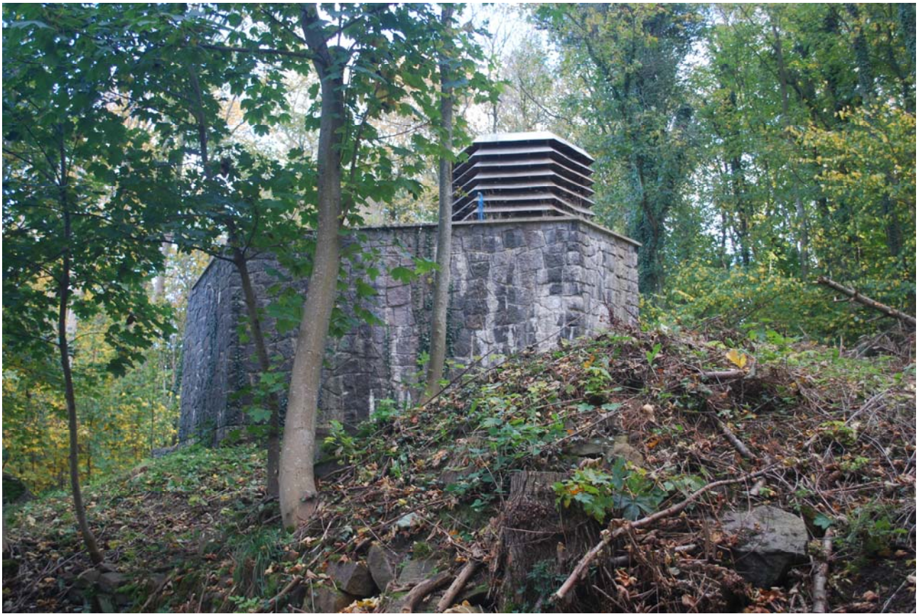
Foto Eigil Jensen Svaneke Vandværk & Pumpestation tegnet af arkitekt Jørn Utzon 1951
